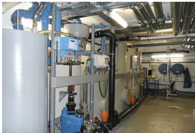
Foto 1 und 2: Im ersten Berliner Passivhaus für Mieter – mit 41 Wohn- und 4 Gewerbeeinheiten – steht im Heizungsraum auf ca. 9 m 2 Stellfläche (ca. 0,1 m 2 pro Bewohner) der Prototyp einer neu entwickelten Grauwasserrecyclinganlage mit vorgeschalteter Wärmerückgewinnung. Er hat eine tägliche Reinigungsleistung von 3 m 3 .
